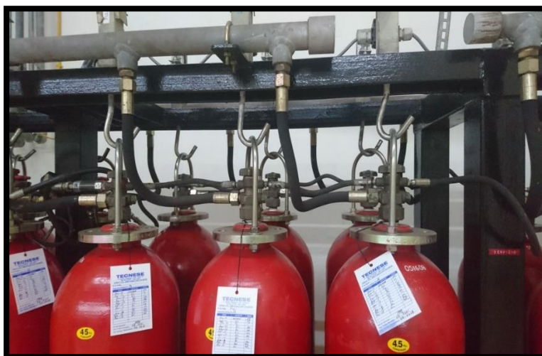
Conexión de los extintores al sistema
